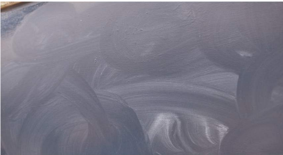
Großflächig arbeiten: Das Poliermittel maschinell gleichmäßig und dünn verteilen und so lange polieren, bis die Optik stimmt
